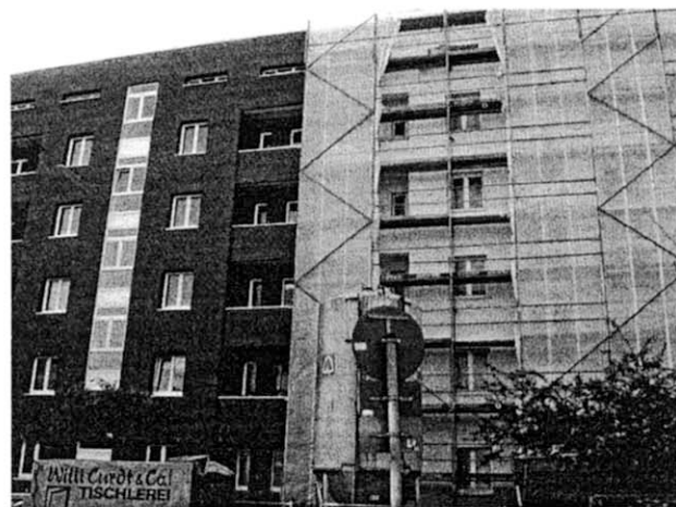
写真7 ハンブルグの外断熱改修
