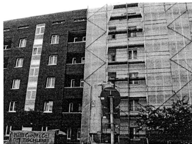
写真7 ハンブルグの外断熱改修
