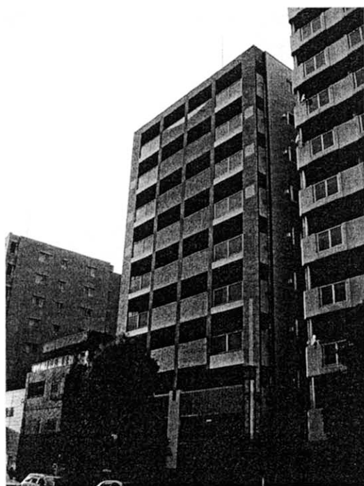
写真3 リリーベル両国北斎通りサーモス
