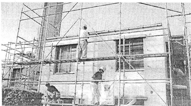
外断熱施工の様子(佐賀県営鍋島団地)
